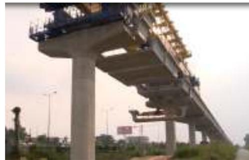
**Ilustración 42. Fabricación de dovelas conjugadas y construcción del viaducto elevado mediante viga lanzadora (metro de Ho Chi Minh) - Fuente: Consorcio Metro-Bog**
