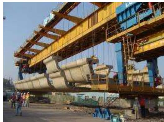
**Ilustración 151.** Izado de dovelas mediante viga lanzadora (metro de Delhi)
