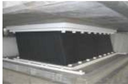
**Ilustración 67. Aparato de apoyo de tipo LRB**
