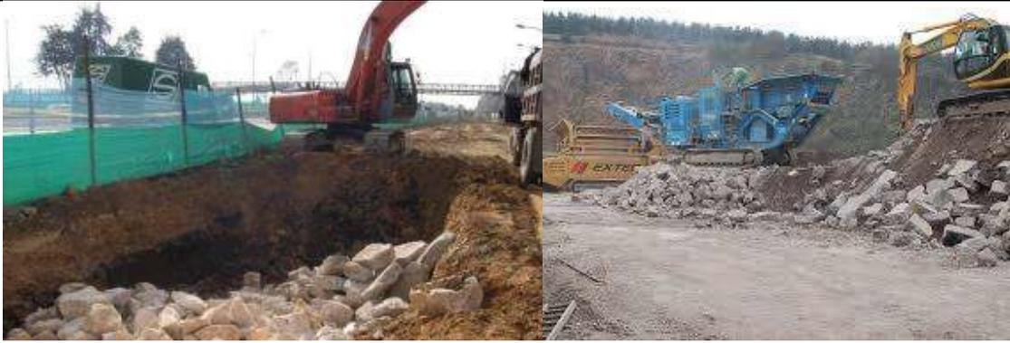
**Ilustración 169. Empleo de material de demolición para el mejoramiento de subrasante**
