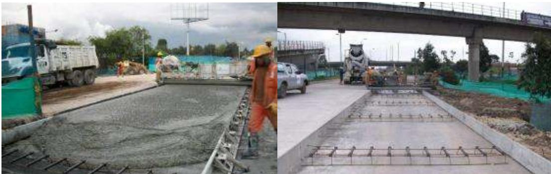
**Ilustración 170. Construcción concreto neumático carril BRT**
