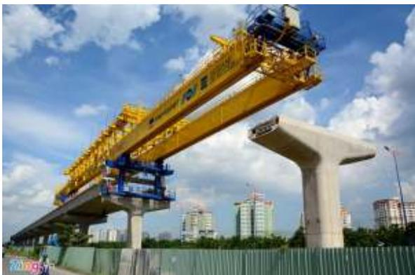
**Ilustración 150.** Viga lanzadora para viaducto en “U” del metro de Ho Chi Minh
