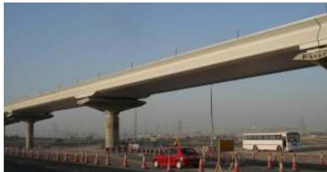
**Ilustración 40. Módulo continuo de dos vanos en Red Line del Metro de Dubai - Fuente: Consorcio Metro-Bog**
