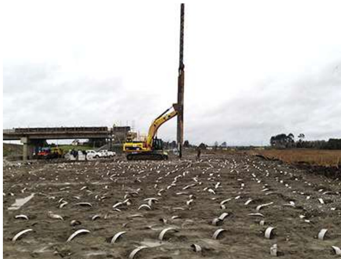
Figura 2.4 Esquema típico de utilización de mechas drenantes
