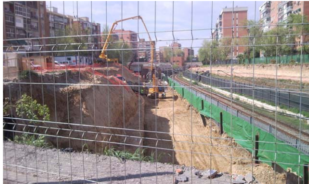
Figura 6.25. Tramo entre Campamento y Empalme, en la L5 del metro
