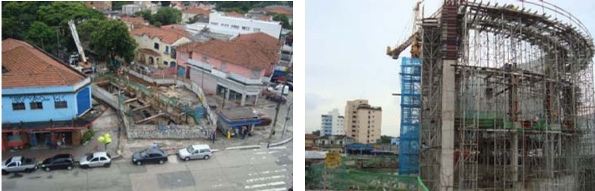
Figura 6.36. Izquierda: acceso por Av. Brasil a la estación Butanta de la línea L4; derecha: estación de Butanta
