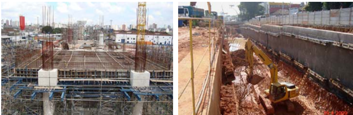
Figura 6.55. Izquierda: patio Tamundateí en la línea L2; derecha: tramo Tamundateí a Vila Sonia de la línea L2
