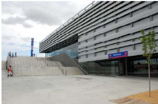
Figura 6.1. Estación de Rivas-Futura (TFM) - Abierta al público en 2008
