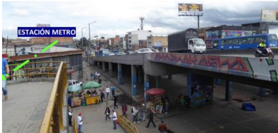
Figura 6.39 Vista de los predios impactados por la estación metro Av. Boyacá y de los puentes a reconstruir aprovechando la intervención
