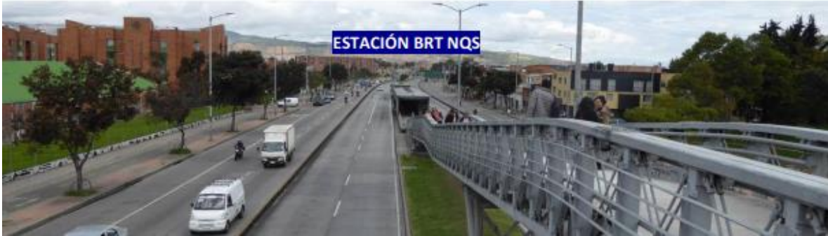
Figura 6.42 Vista de la estación de Transmilenio NQS
