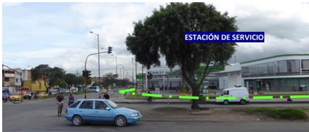
Figura 6.33 Vista de la estación de servicio impactada en el enlace entre Av. Villavicencio y Av. Primero de Mayo
