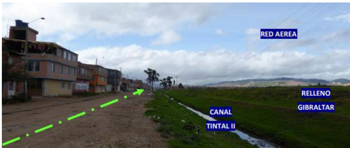
Figura 6.24 Vista del Canal Tintal II a la altura del relleno sanitario Gibraltar
