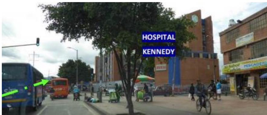
Figura 6.37 Vista del Hospital Kennedy sobre la Av. Primero de Mayo
