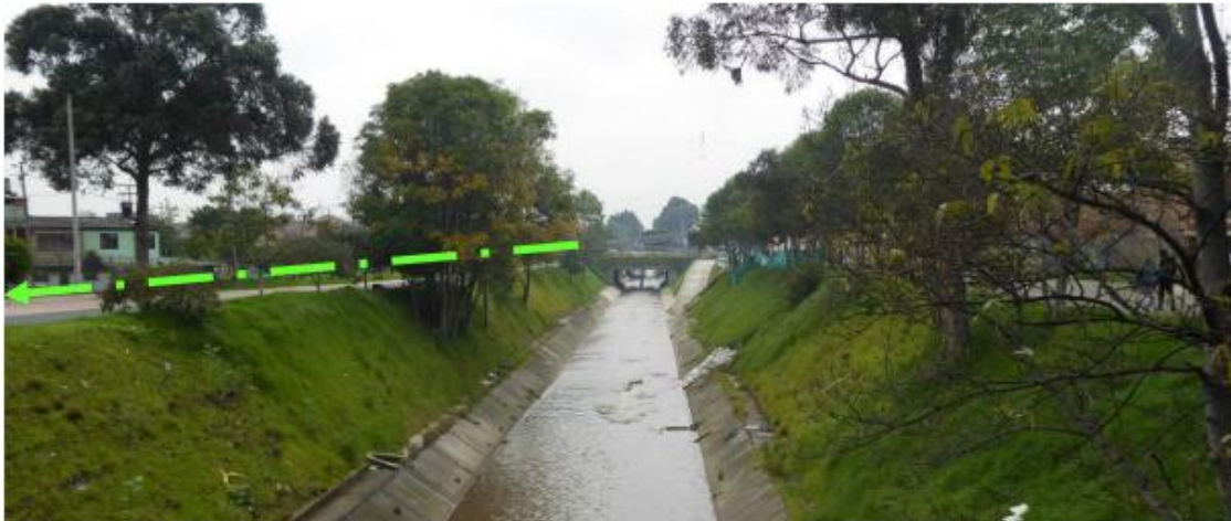
Figura 6.44 Vista del canal Fucha en el tramo entre NQS y La Fragua, con una anchura notable de la calle
