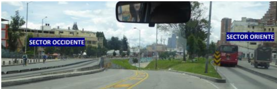
Figura 6.53 Vista del acceso al intercambiador deprimido del BRT en la Av. Caracas en la zona del proyecto Estación Central
