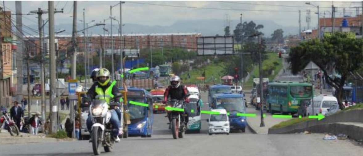
Figura 6.28 Vista de la intersección de la Av. Villavicencio con la Av. Cali
