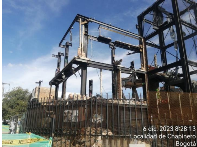
Elementos estructurales posterior a su demolición.
